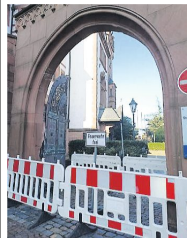
Aktuell werden Schäden am Schloss dokumentiert. BILD: STADT WEINHEIM
